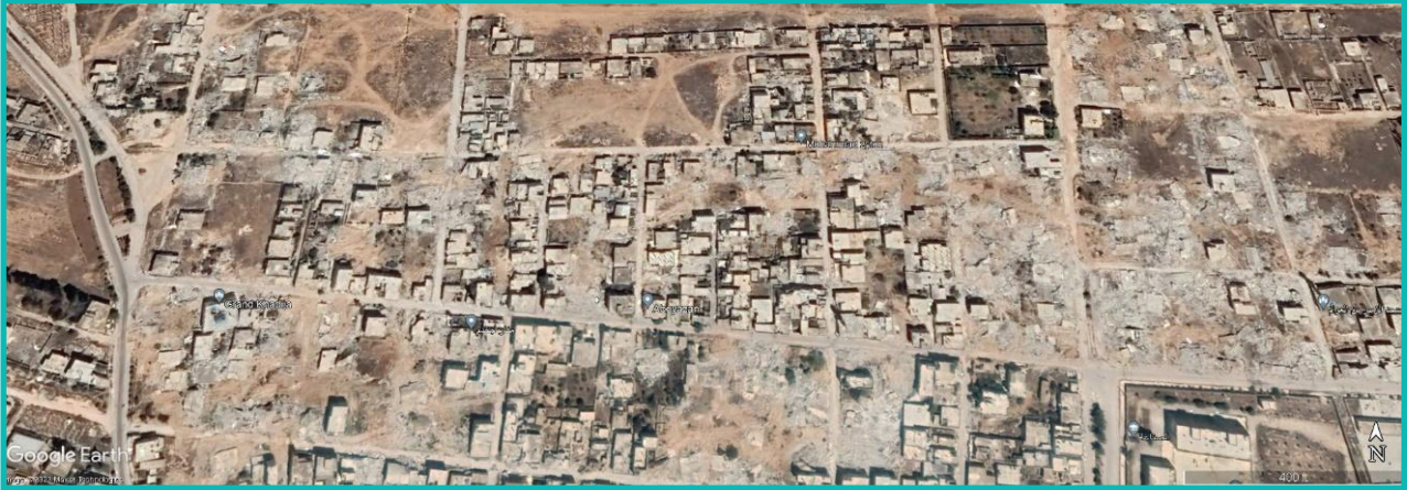
■ رسم توضيحي رقم (74) هدم المباني السكنية بعد استعادة النظام وحزب الله السيطرة على القصير بين مارس 2013 حتى اغسطس 2014.
